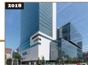
都心エネルギーマスタープランの先導的事業となる創世エネルギーセンターが供給を開始しました。
